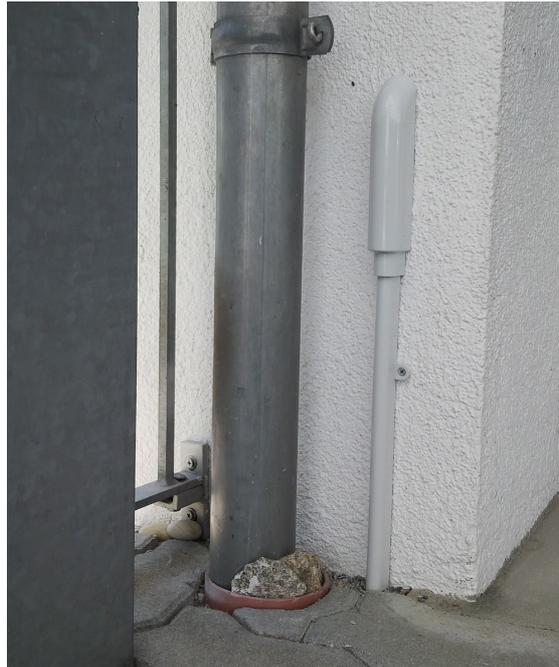
Abb. 16 – Überirdische Hauseinführung [G. Bartl | Gabocom]
